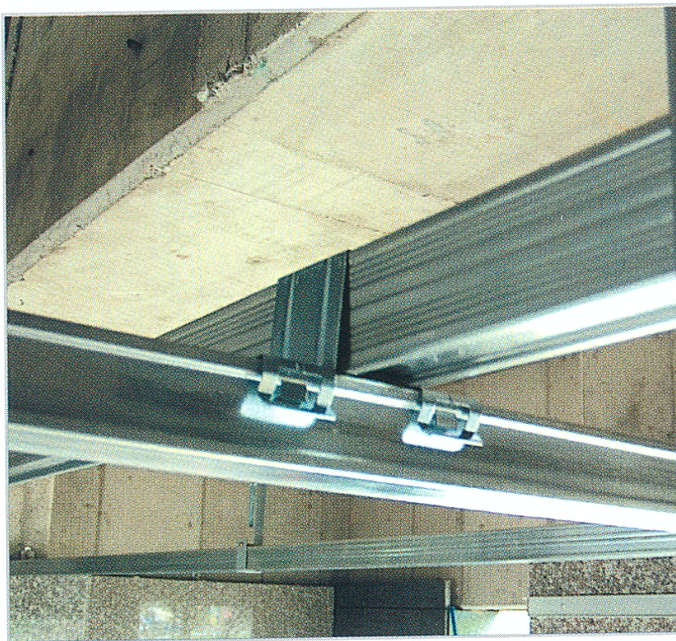
〈CANOTILE 설치 상세도 : SQ-BAR공법〉
