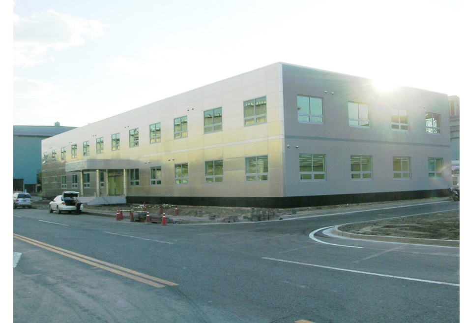
포항 STS서브센터 (모듈수 68 / 연면적 2,205㎡ / 2층 / '07.05 ~ '07.08)
